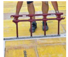
Einfädeln des Temperierungsmoduls
