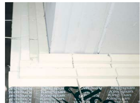
Zweischaliger Wandbau mit KS und einem Hochleistungs­dämmstoff (z.B. KS* Eco) für den Passivhaus-Standard
