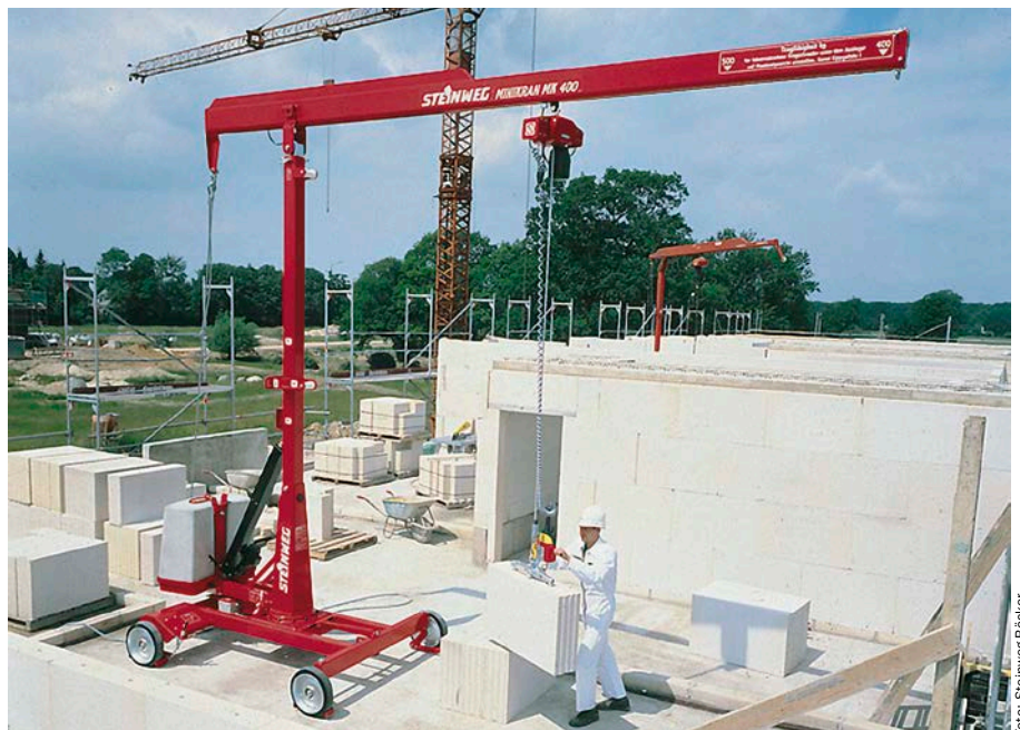
Arbeiten mit dem Versetzgerät
