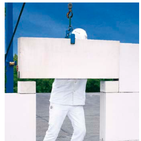
Versetzen eines KS-FTS-Fertigteilsturzes. Allgemeine bauaufsichtliche Zulassung Z-17.1-621
