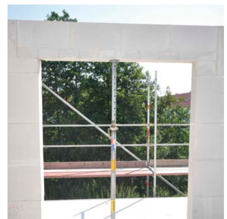
Überdeckung einer Türöffnung mit einem KS-Flachsturz und Übermauerung aus Passtücken
